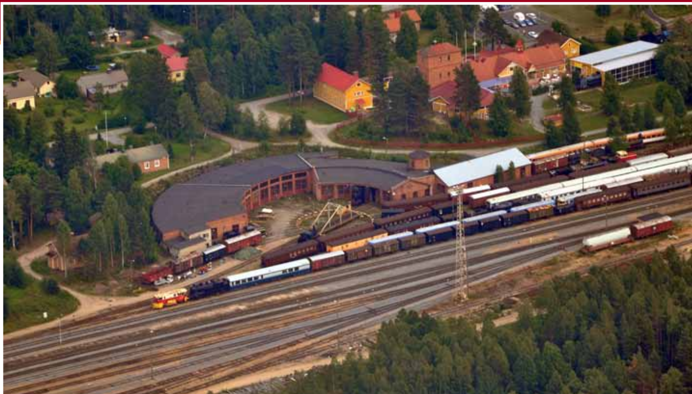
Kesäinen Museovarikko ilmasta nähtynä. Vetutallin edessä kaluston säilytysraiteet. Vasemmalla, puiden katveessa on kaksoisvahtitupa. Taustalla mm. Veturi- piston rakennuksia. Kuva Aki Grönblom, 22.7.2009
