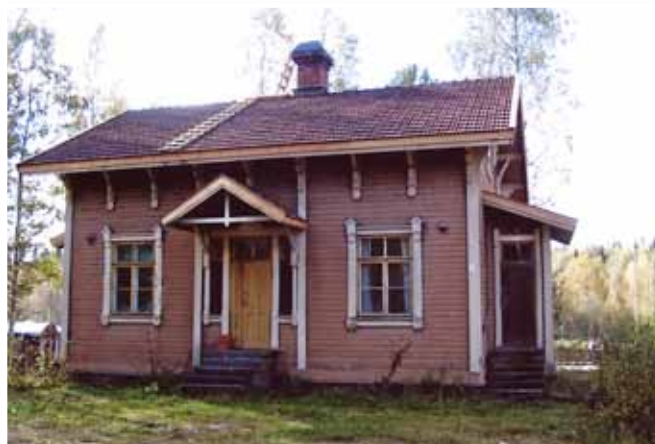
Kaksoisvahtituvan tiilikatto kunnostettuna. Ulkopuolinen kunnostus jat- kuu vuonna 2011.
