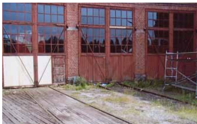
Veturitallin oviremontti etenee. Pilttun 8 ovet ovat jo saaneet uuden lau- doituksen ja ikkunaruuudut. Pilttuiden 9 ja 10 ovet odottavat vuoroaan.
